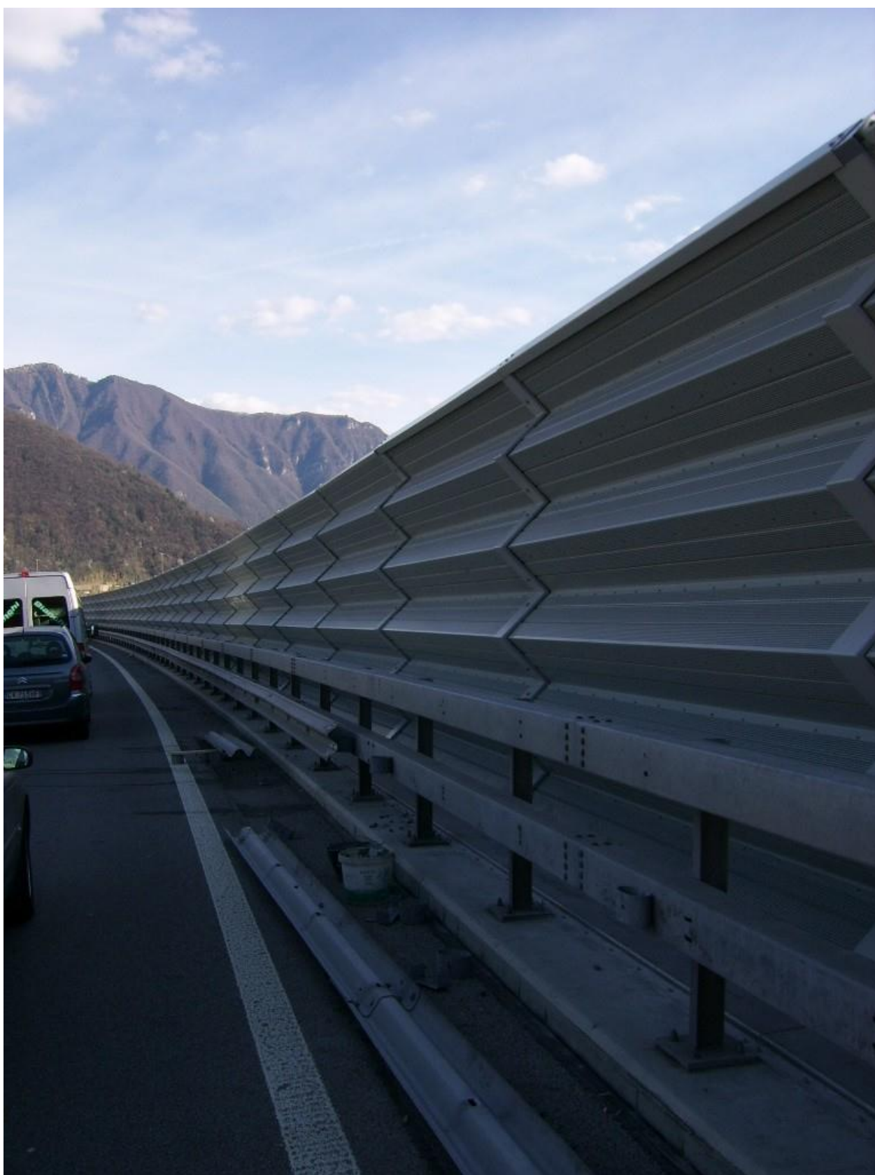
Lomená absorpční protihluková stěna na dálnici E 35 u Lugana – instalace svodidel
