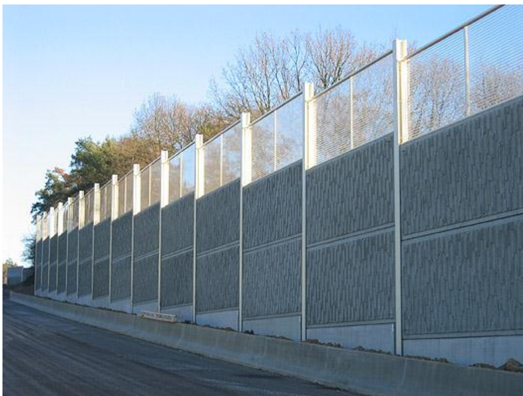
Kombinovaná protihluková stěna - beton a průhledná horní část stěny - Image KOHLHAUER® Clearview
