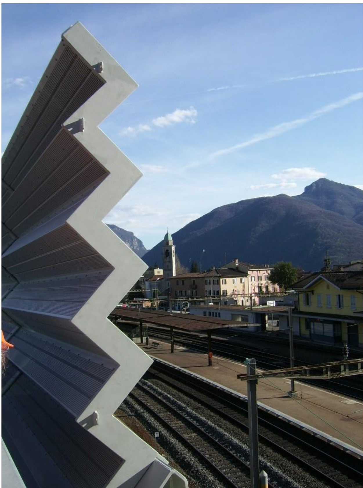
Protihluková stěna Melide – souběh železniční trati a dálnice E35 severně od Lugana
