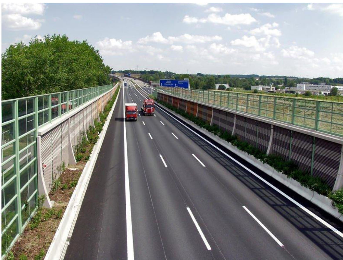
Dálnice u Chemnitz – protihluková stěna LIADUR
