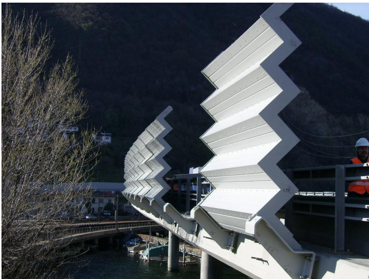
Dálnice E35 – severně od Lugana (Melide) přechází přes jezero Lago di Lugano – protihluková stěna na mostě
