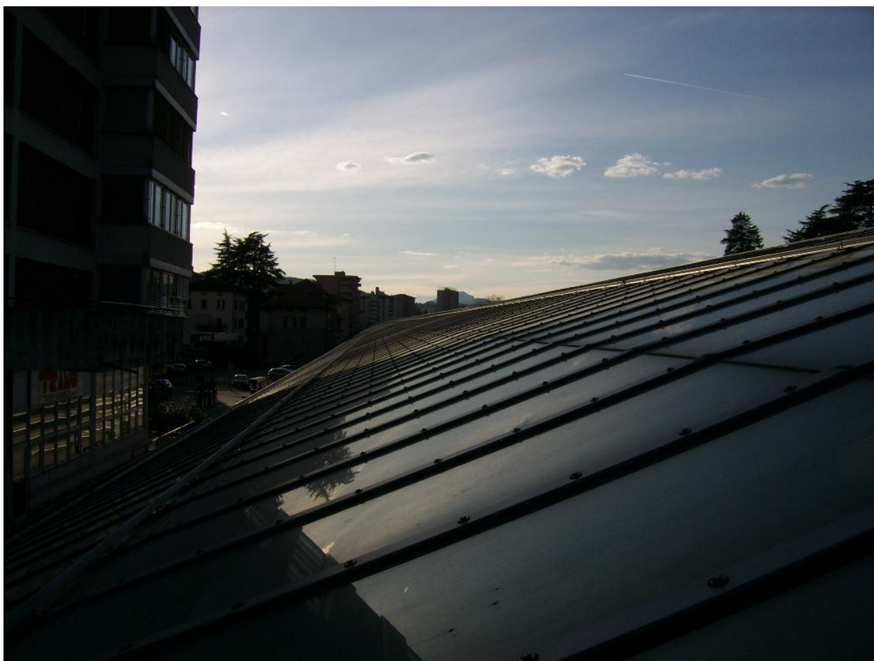
Dálnice E35 – hraniční přechod Chiasso (Švýcarsko) – Como (Itálie) – protihluková stěna s překrytím, ochrana velmi blízkých obytných domů
