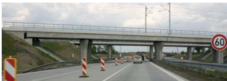
Provizorní provoz v prostoru před výjezdem 370 na Bohumín. V těchto místech prozatím hotová dálnice končí
