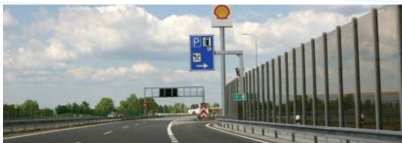
Příjezd k odpočívce Antošovice v km 368, směr Polsko
