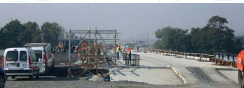
Most přes železniční trať a Odru u Mankovic
