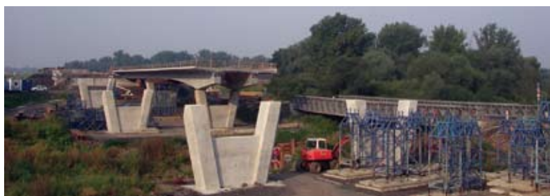
Rozestavěný most přes Olši, km 375,300
