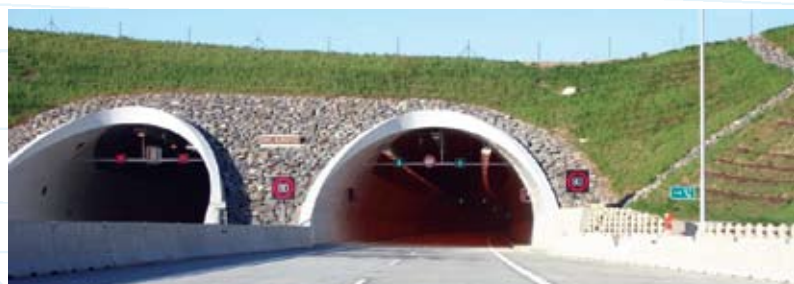
Brněnské portály tunelu Klimkovic
