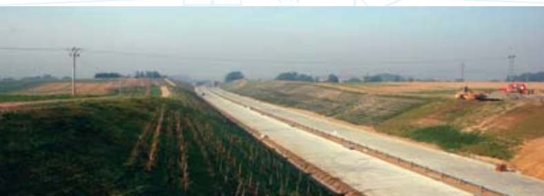
Nadjezd silnice Pustějov–Kujavy, směr Brno
