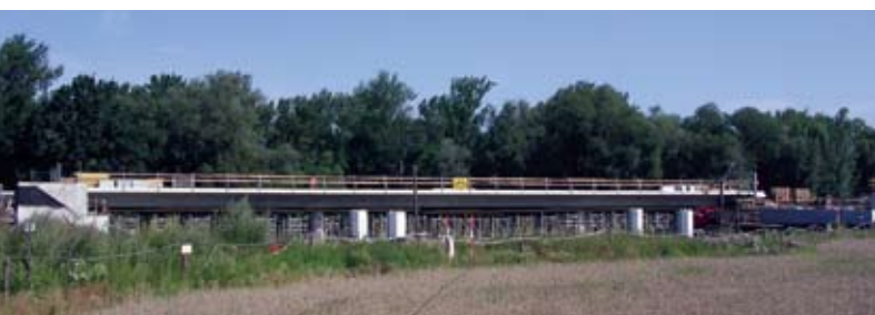
Most přes inundaci Olše a přeložku polní cesty, km 374,450
