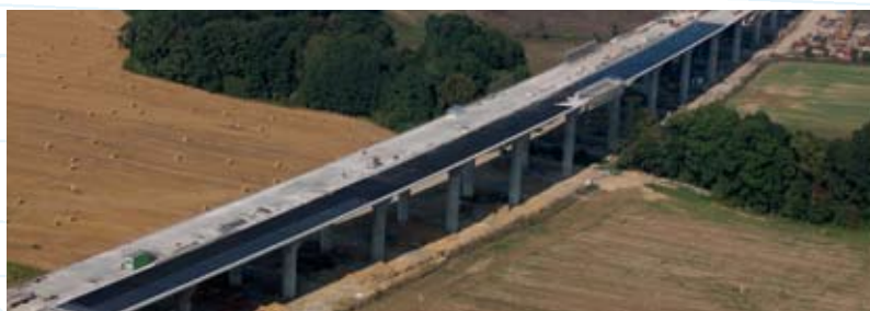
Výstavba estakády přes údolí říčky Luhy (655 m)
