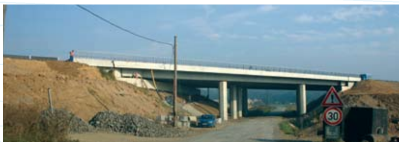
Most přes silnici Pustějov–Bílov
