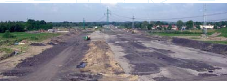
Začátek rozestavěného úseku u Bohumína, km 164
