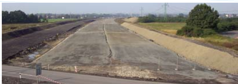
Dálnice s přeložkou silnice I/67, km 165,500
