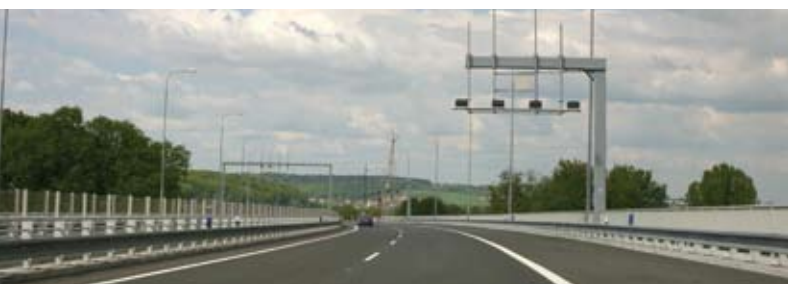
Na mostě přes řeku Opavu. Připravené portály pro MÚK
