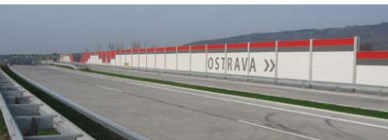
Protihluková stěna chránící obec Loučka
