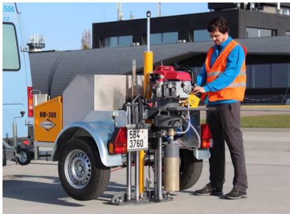
Obr. 5 Odběr jádrového vývrty, zdroj: CDV
