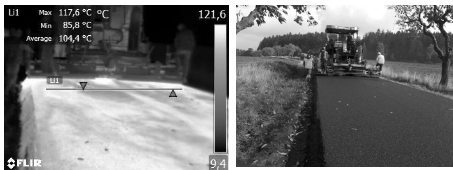
Obr. 12 Kontrola teplotní homogenity asfaltové směsi
