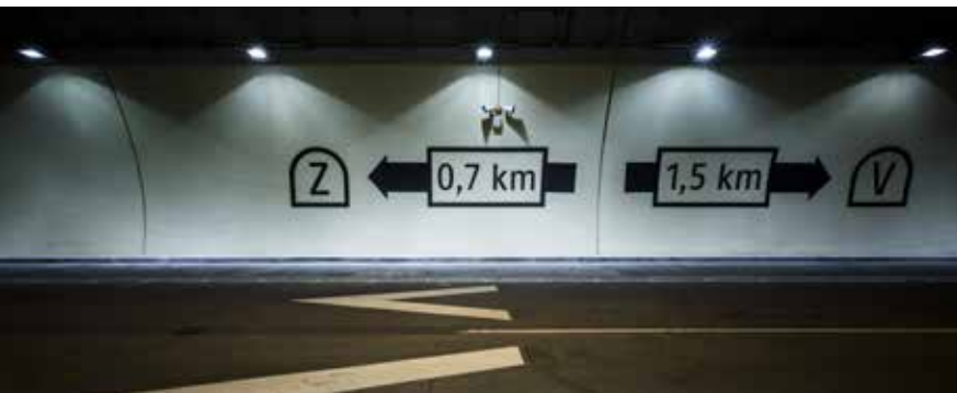
Žilina, dálnice D3, úsek Žilina (Strážov) – Žilina (Brodno) – tunel Považský Chlmec
