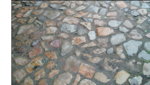
Detail nepravidelného kladu
