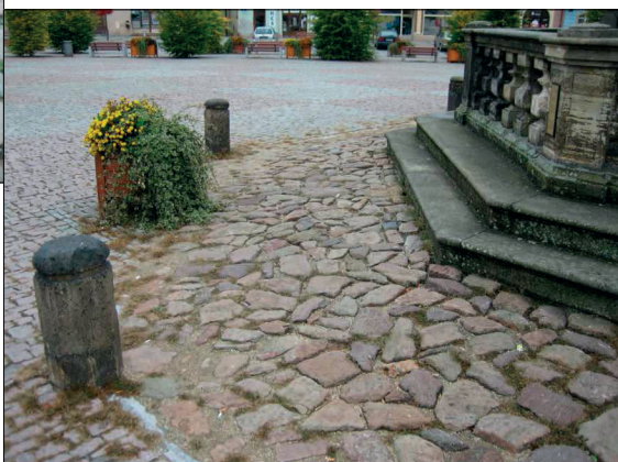
Detail nepravidelného kladu
